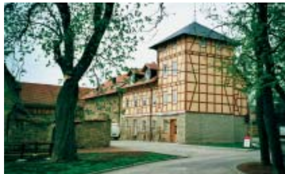
Verwertung des Gutshofes Großobringen / Neuer Zustand 2001 (Foto: ThLG; 2001)
