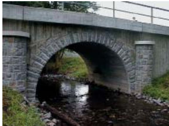
Neubau der Weidabrücke an der Leitlitzmühle (Foto: Ingenieurbüro Kleb GmbH; 2001)
