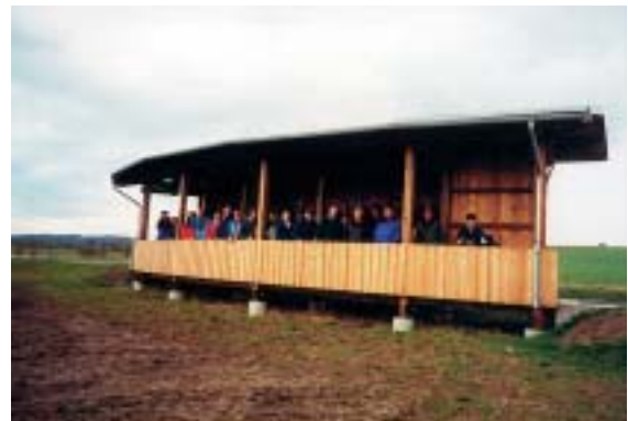
Besuchergruppe im gerade fertiggestellten neuen Informationspavillon (Foto: TLVwA; 2001)
