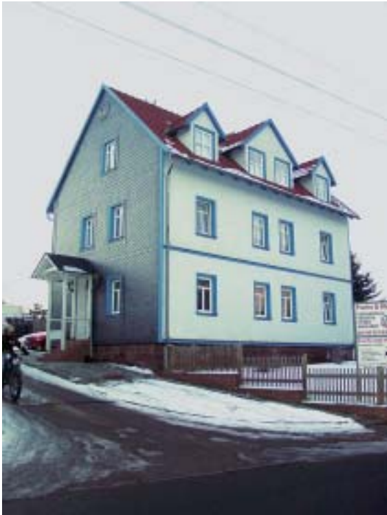
Alte Schule nach der Sanierung (Foto: FNA Gotha; 2002)
