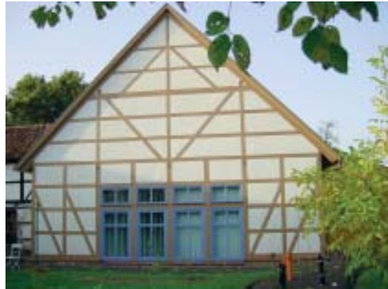
Die Scheune als attraktives Dorfgemeinschaftshaus (Foto: Planungsgruppe 91; 1999)
