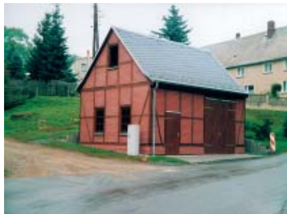
Neubau des Feuerwehrhauses (Foto: FNA Gera; 1999)
