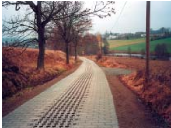
Ausgebauter ländlicher Weg in der Gemarkung Leitlitz (Foto: FNA Gera; 1999)
