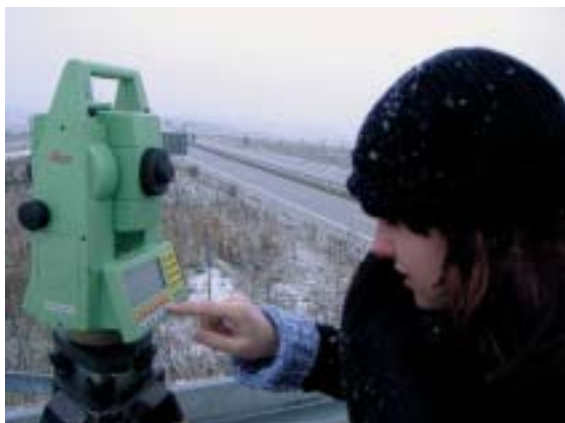
Vermessungsarbeiten in einem Flurbereinigungsverfahren an der Autobahn BAB 71 (Foto: TMLNU; 2001)
