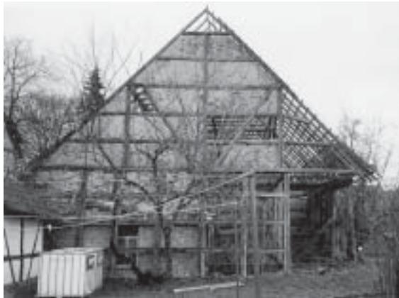
Pfarscheune vor der Sanierung (Foto: Planungsgruppe 91; 1999)
