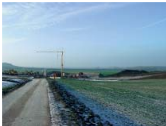
Wiederherstellung eines zerschnittenen Wirtschaftsweges (Foto: FNA Gotha; 12/2001) 2)
