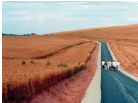
Wanderer auf dem ausgebauten Brochthäuser Weg (Foto: TG Jützenbach; 2001)
