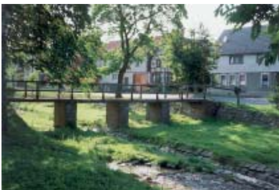
Der Pommersteg vor der Sanierung (Foto: Planungsgruppe 91; 1999)
