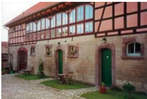
Scheune wurde zu Wohnungen umgenutzt (Foto: Thüringer Landesverwaltungsamt; 2001)
